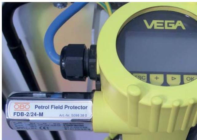
Рис. 3.66: Сенсор с Petrol Field Protector (см. пункт 7 на рис. 3.68)
