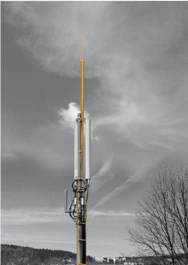
Рис. 2.72: Мачта мобильной радиосвязи с токоотводом isCon®
