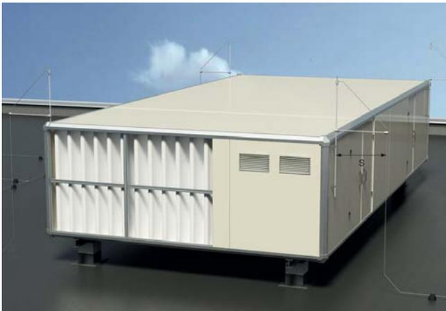
Рис. 2.28: Изолированный молниеприемник с разделительным интервалом (s)
