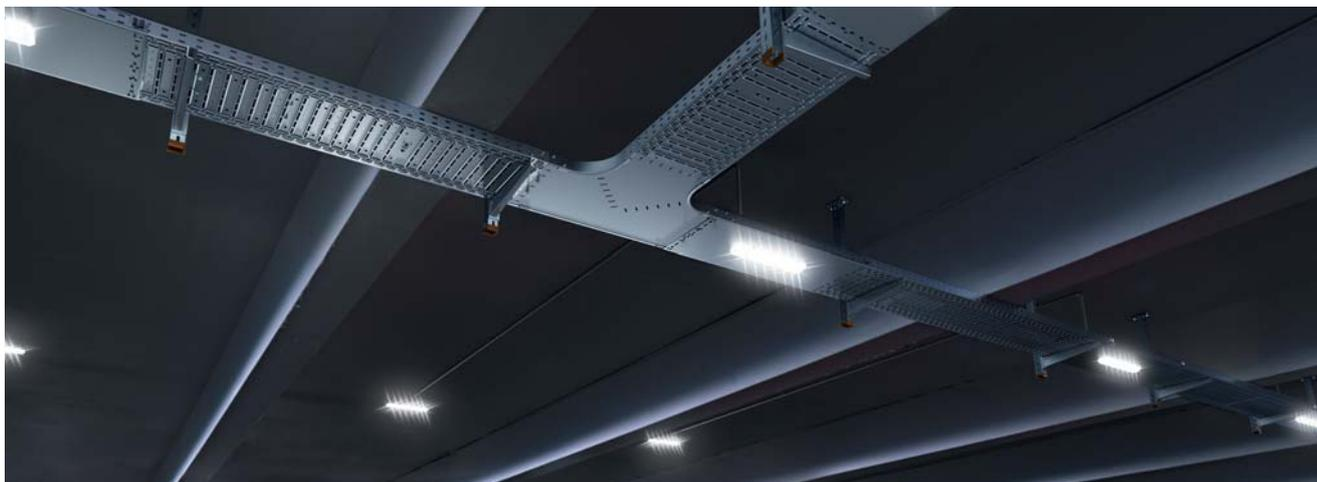
Рис. 3.29: Светодиодная система освещения крытой автостоянки
