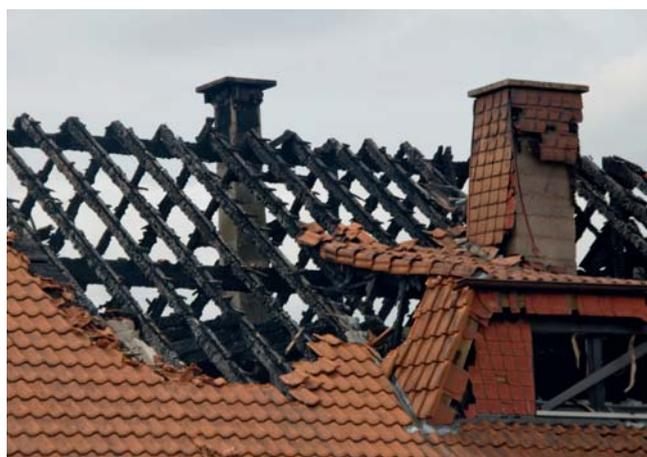
Рис. 1.19: Повреждения здания от прямого удара молнии
