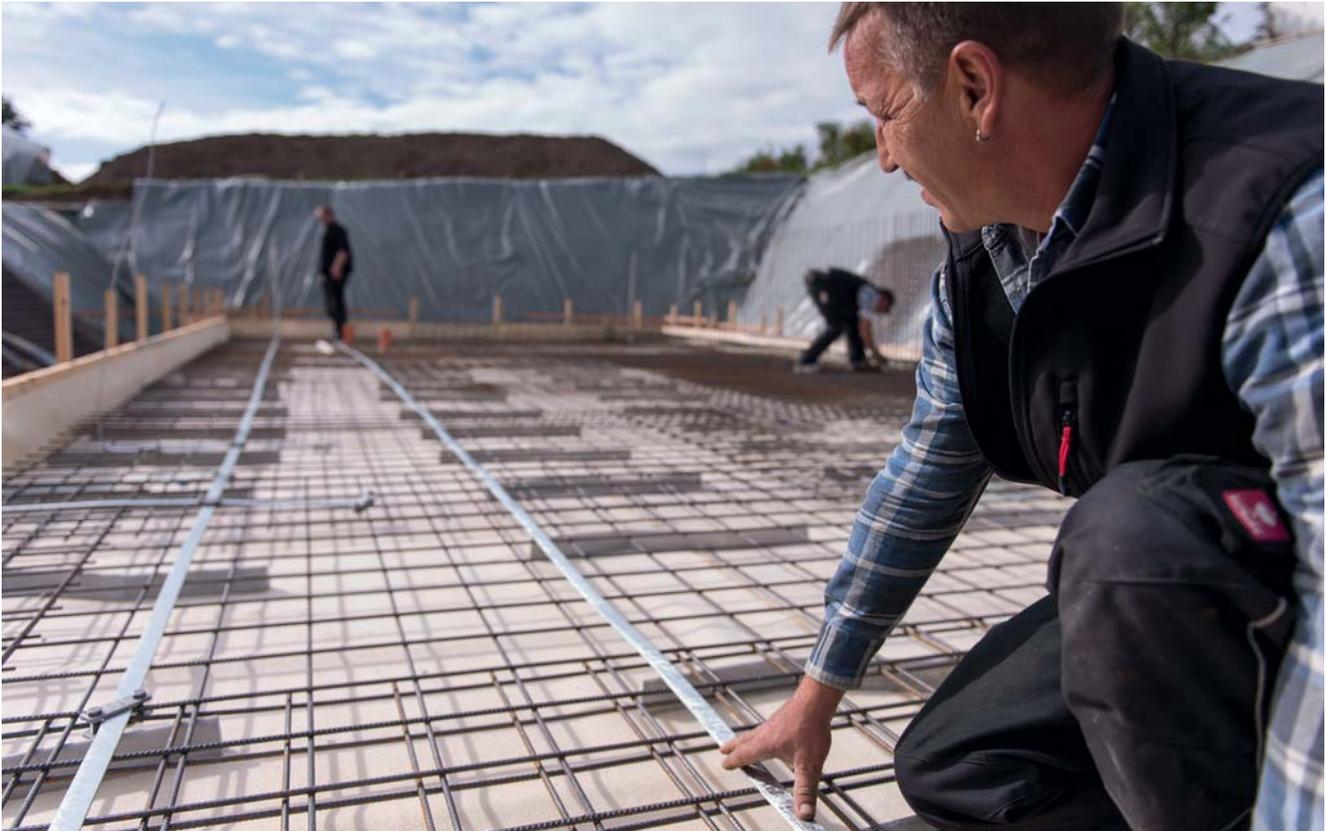
Рис. 2.75: Прокладка фундаментного заземлителя
