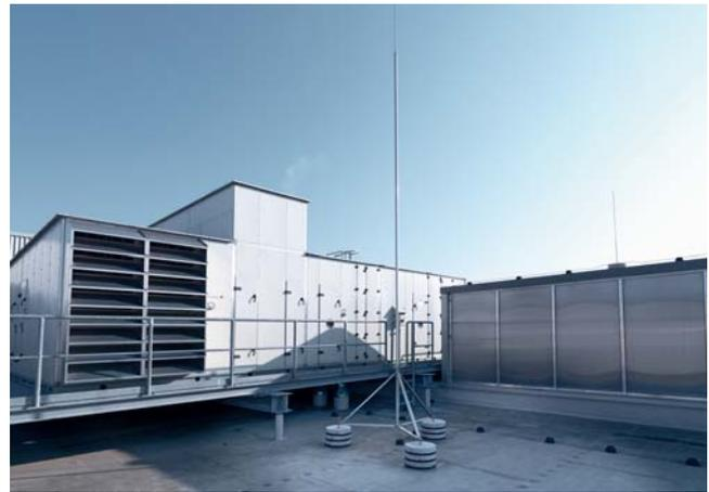
Рис. 2.22: Изолированная молниезащита с молниеприемной мачтой isFang
