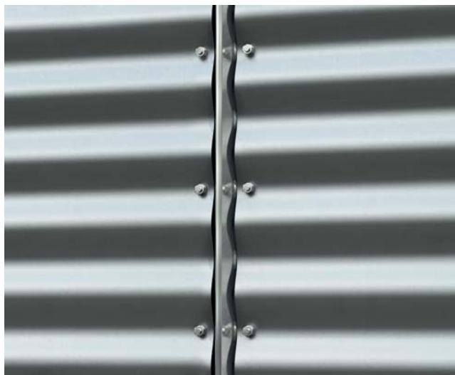
Рис. 2.52: Пример: использование горизонтально соединенных элементов фасада в качестве токоотвода
