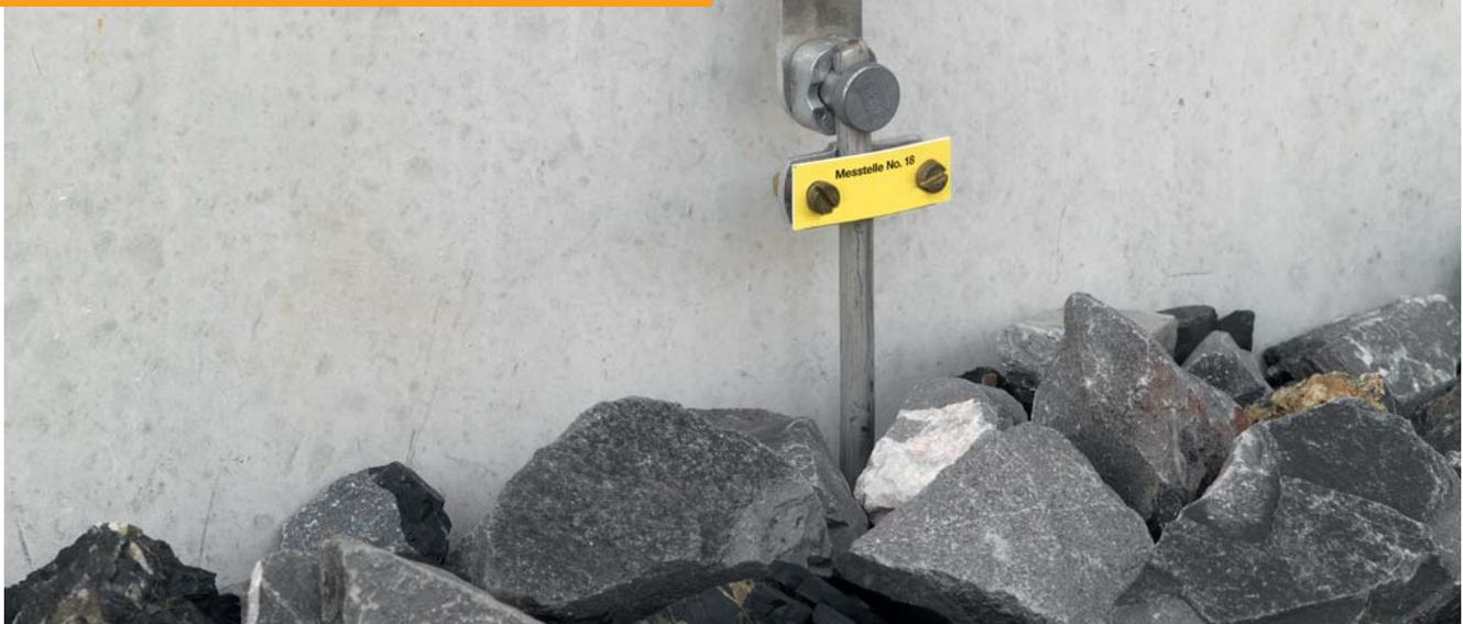
Рис. 2.48: Точка измерения на вводе в землю
