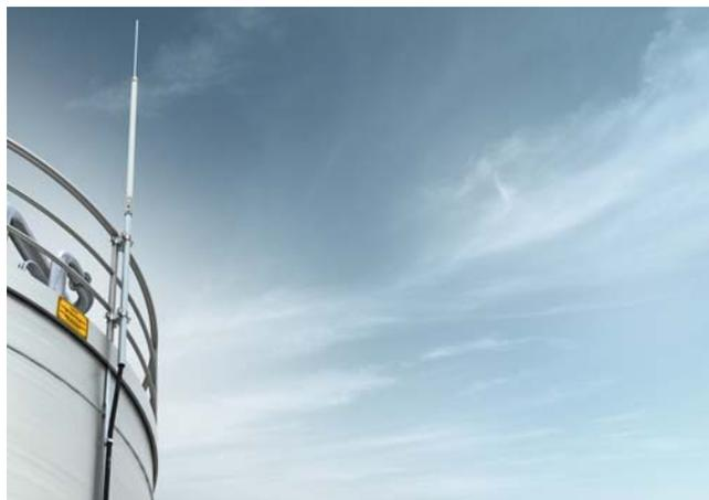
Рис. 2.58: Изолированная молниезащита с токоотводом isCon®
