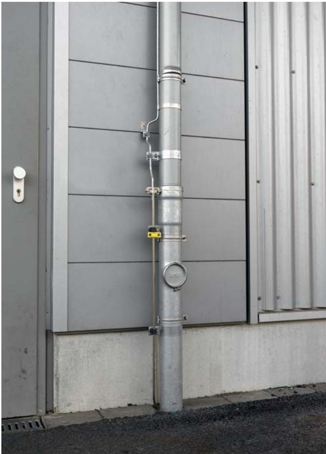
Рис. 2.18: Токоотвод молниезащиты на водосточном стояке
