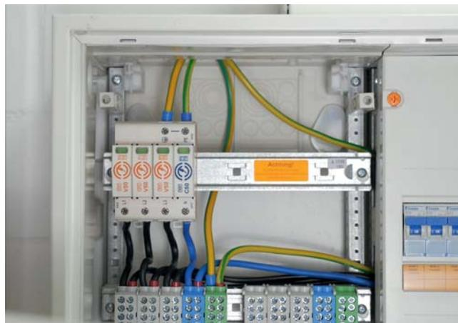
Монтаж комбинированного разрядника V50 типа 1+2 в зоне до счетчика
